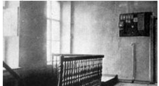
Лестница в подвал Ипатьевского дома, по которой царскую семью вели на убийство
