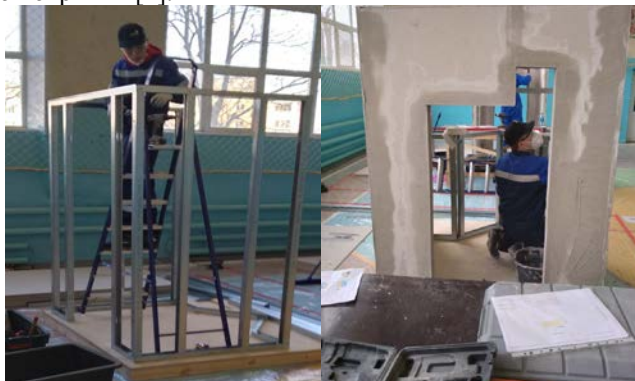
Рис. 1. Монтаж металлических каркасов и обшивка их гипсовыми строительными плитами с оштукатуриванием
